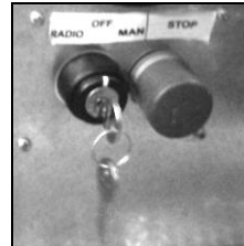
Kluczyk na obudowie elektropompy Key on electropump box Schlüssel auf Elektropumpenbox
